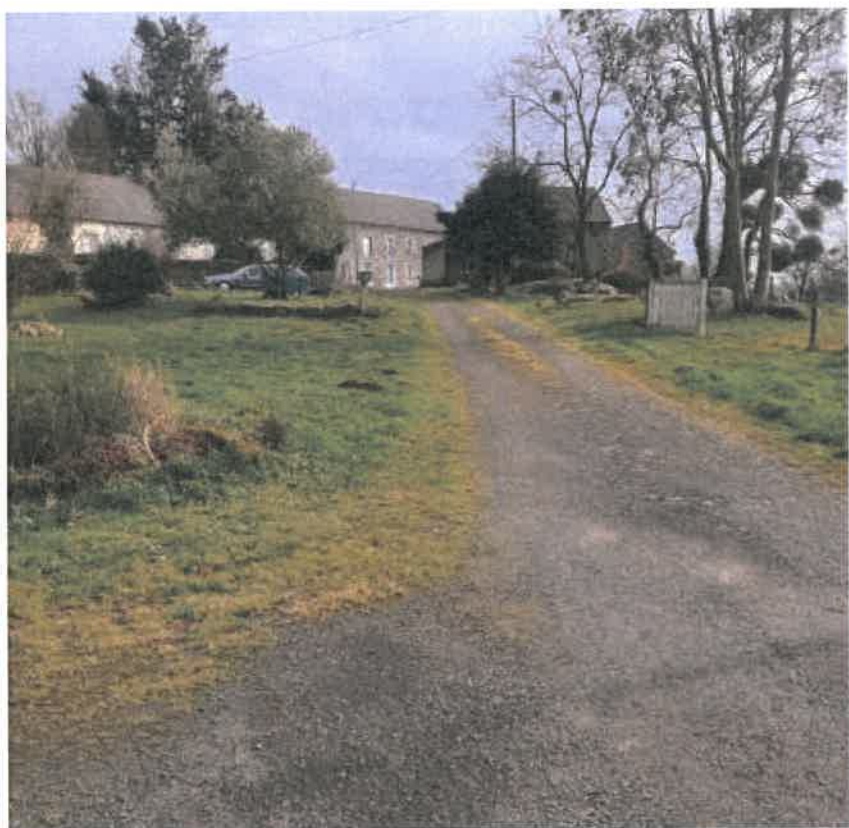
Entrée de voie n°57 « la Plançonnais » permettant d'accéder aux parcelles 102 ZM 64, 102 ZM 63 et 102 ZM 58 La partie à déclasser de la voie n°57 commence au milieu de cette voie.
